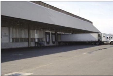
Foto 12. Operación en bodega frigorífica.
