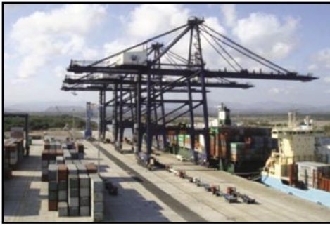
Foto 7. Operación en Muelle con grúas Pórtico.
