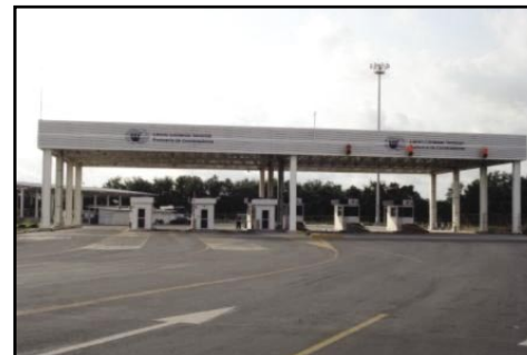
Foto 15. Puertas de Acceso/ Salida de la NUTEC.
