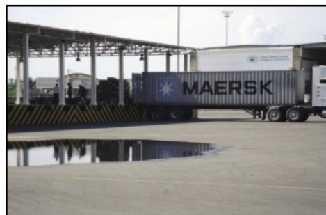
Figura 19. Aduana para contenedores manejados vía autotransporte.
